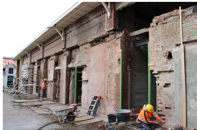
► Renovatie buitengevels Slachthuis.
